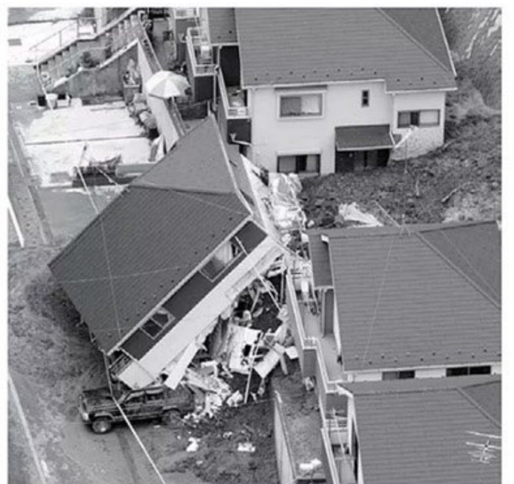
'08年8月末豪雨での、八王子の土砂崩れ
